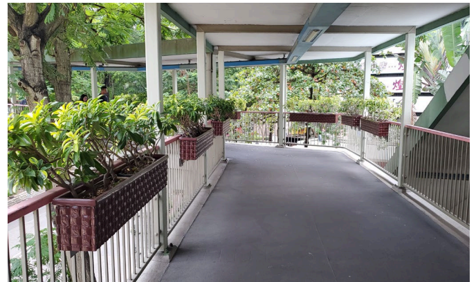
行人天桥上的栏杆花槽
