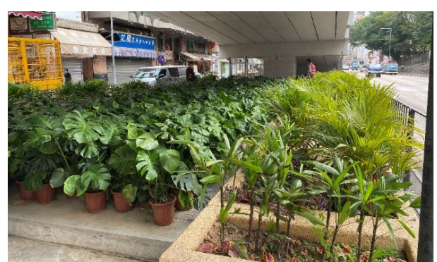
行車天橋下的綠化工程
